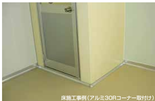
床施工事例（アルミ30Rコーナー取付け）
